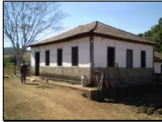
Fig. 72: Rural estilo Colonial Fonte: Equipe Técnica Municipal
