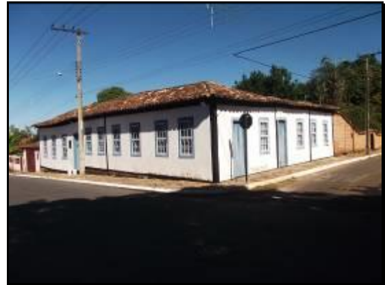
Fig. 52: Arquitetura Colonial Fonte: Equipe Técnica Municipal
