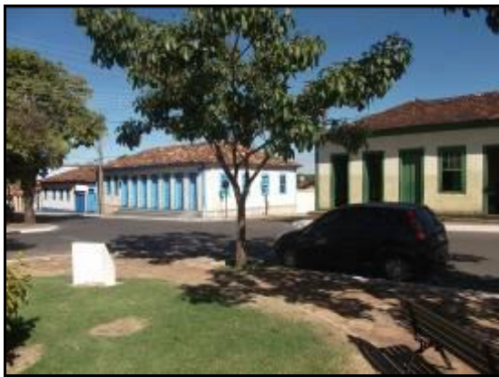
Fig. 51: Arquitetura Colonial Fonte: Equipe Técnica Municipal
